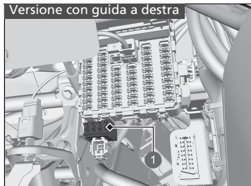
1 Scatola fusibili B
