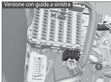
1 Scatola fusibili B
